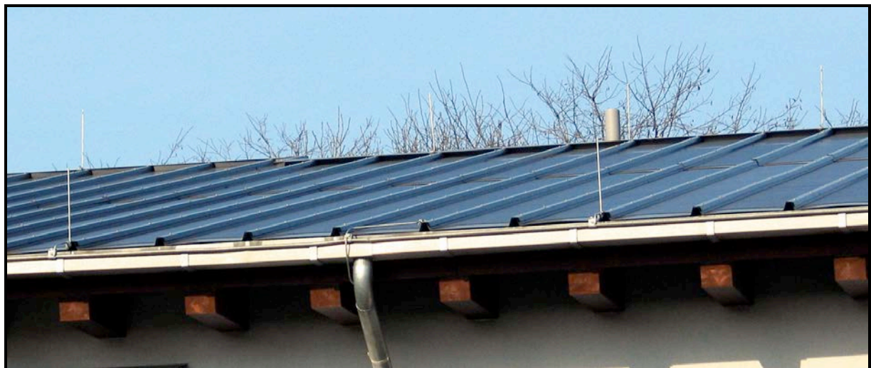
Bild 27: Blitzschutz von dachintegrierten PV-Anlagen
