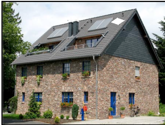
Bild 22: Einhaltung des Trennungsabstandes zwischen Fangeinrichtungen und metallenen Dachaufbauten
